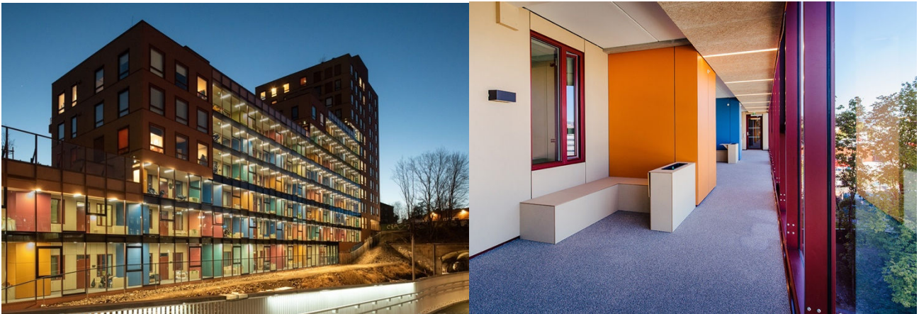
Figur 13: Tigergården ved Ensjø i Oslo ble nominert til Oslo Bys arkitekturpris i 2023. For å løse støykrav i forbindelse med jernbanelinje på nordøstsiden av tomten, er det en innglasset svalgang til inngangsdørene. For å aktivisere svalgangen er det bl.a. etablert sitteplasser til hver boenhet (Kilde: Skanska/Code arkitekter). Mer info om prosjektet kan leses her .
