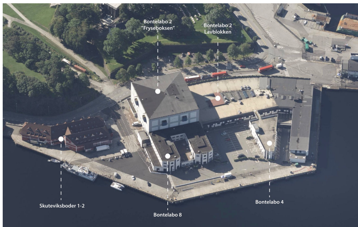
Figur 4: Oversiktsbilde dagens situasjon
