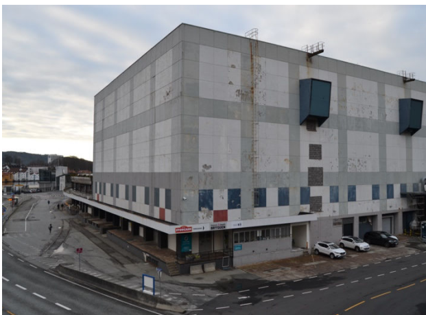
Figur 2: «Fryseboksen», sett fra Sverresborg.
