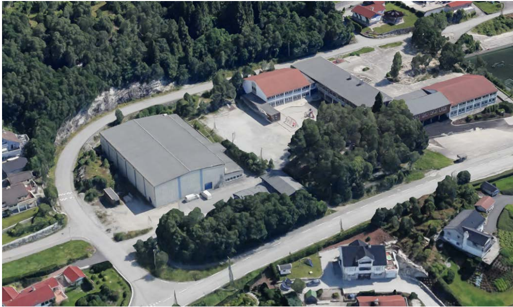
Figur 8 - Bjørnarhallen og Garnes skole sett fra nordvest
